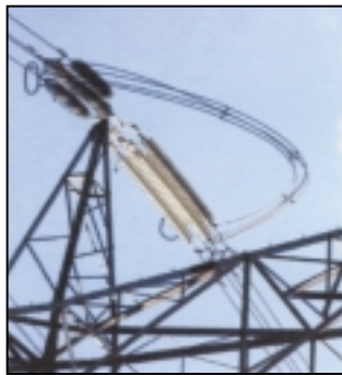
El MIC se ocupará de reubicar los servicios públicos para permitir la construcción
